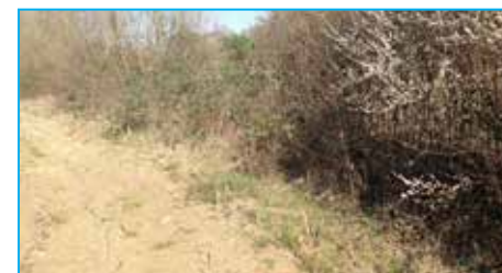
un esempio di fosso non correttamente mantenuto
