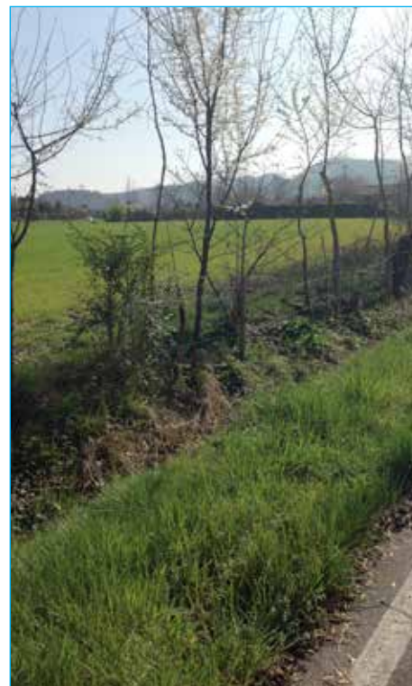
un esempio di fosso correttamente pulito e risezionato
